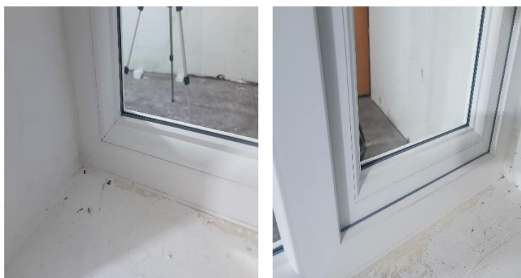
Imagen 4. Sellamiento contra el vano.
