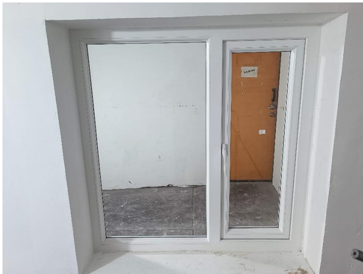
Imagen 1. Vista general de la ventana
